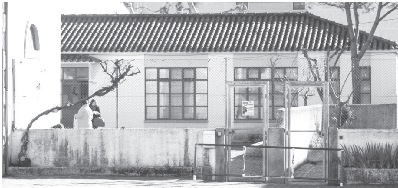
A antiga Escola do Matadouro está a ser requalificada para ali ser instalada a sede da ERID
