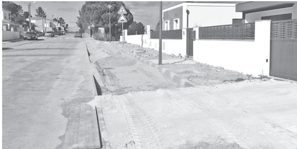
Passeios e zonas de estacionamento estão em fase de conclusão
