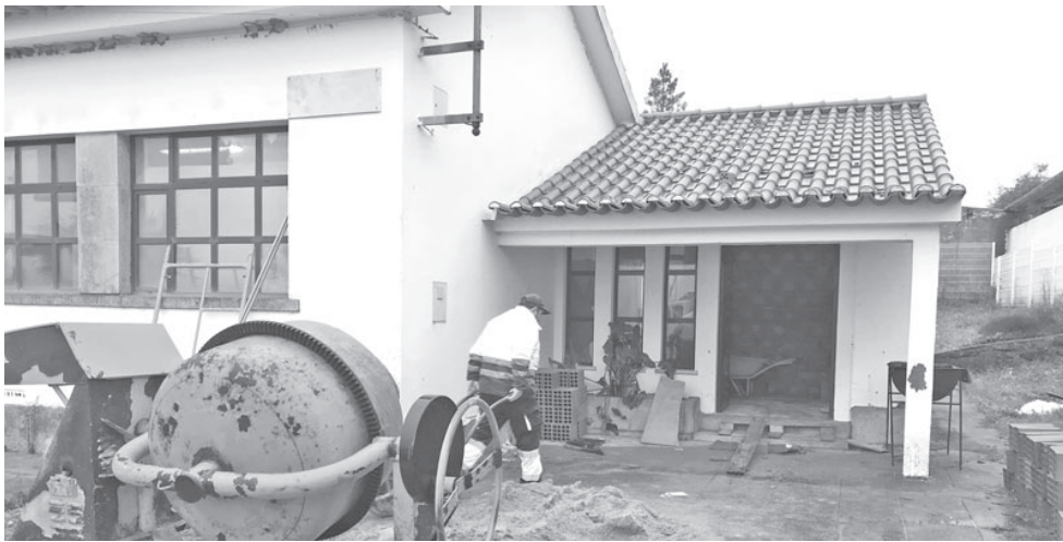
As obras deverão estar concluídas nas próximas semanas
