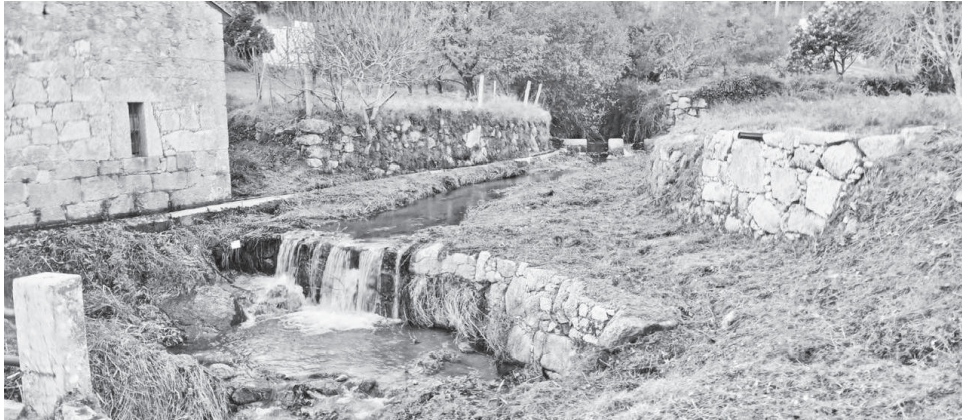
As intervenções mitigam os efeitos ambientais dos incêndios do verão de 2025
