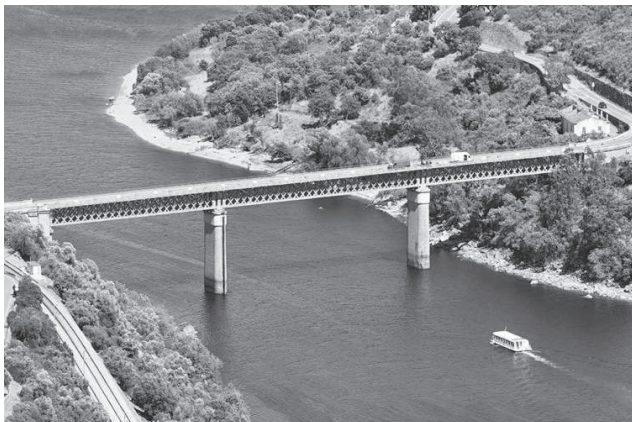
A ponte que une dois concelhos
