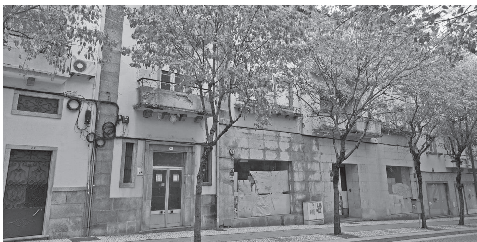
O edifício da antiga Pensão Arraiana situa-se na Avenida 1.º de Maio
